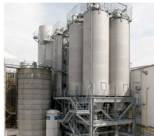
Verladesilos für die Auslieferung loser Ware durch Silofahrzeuge
